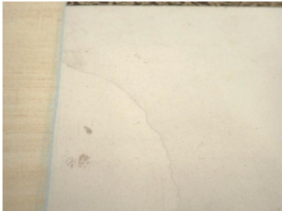
修理前 旧補修の汚れ
